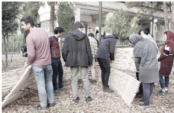
مونتاژ کردن قوس ها ASSEMBLING ARCHES
