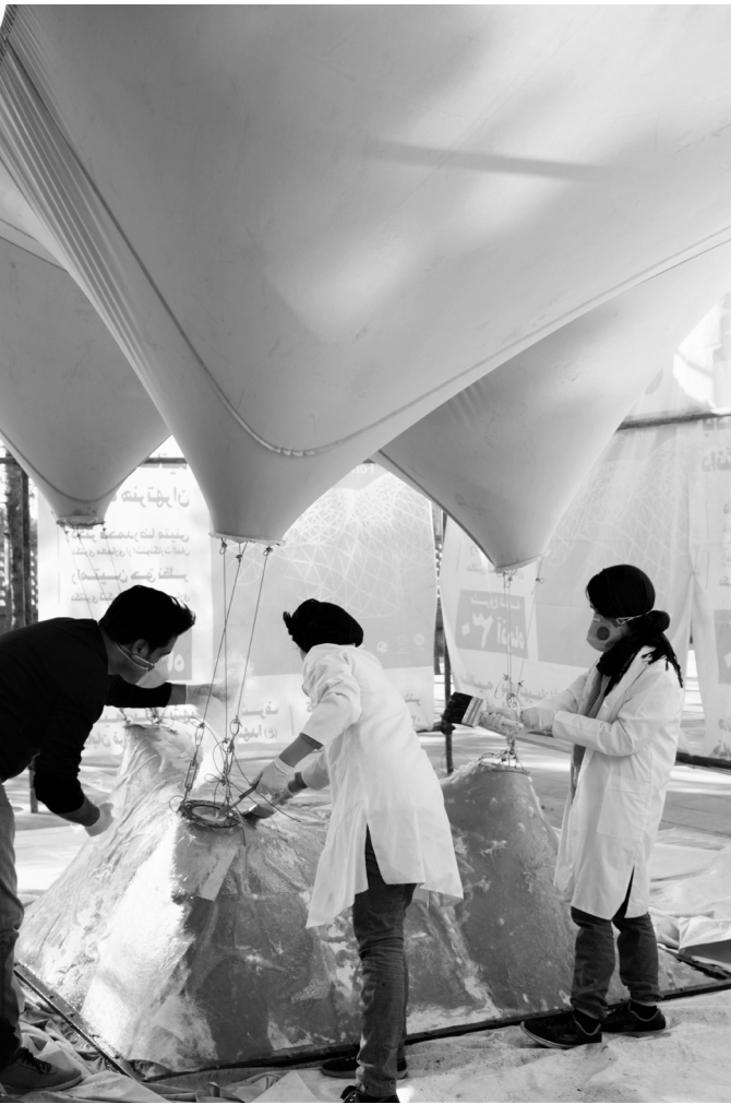
پس از ایجاد مسیر ستون ها، به وسیله پارچه فرم ستون ها تکمیل گردیده. سپس تمام سطح سازه به وسیله ی GFRP مقاوم سازی شده است. After creating the path of the columns, their form is completed by the fabric. Then the entire surface of the structure is reinforced with GFRP.
