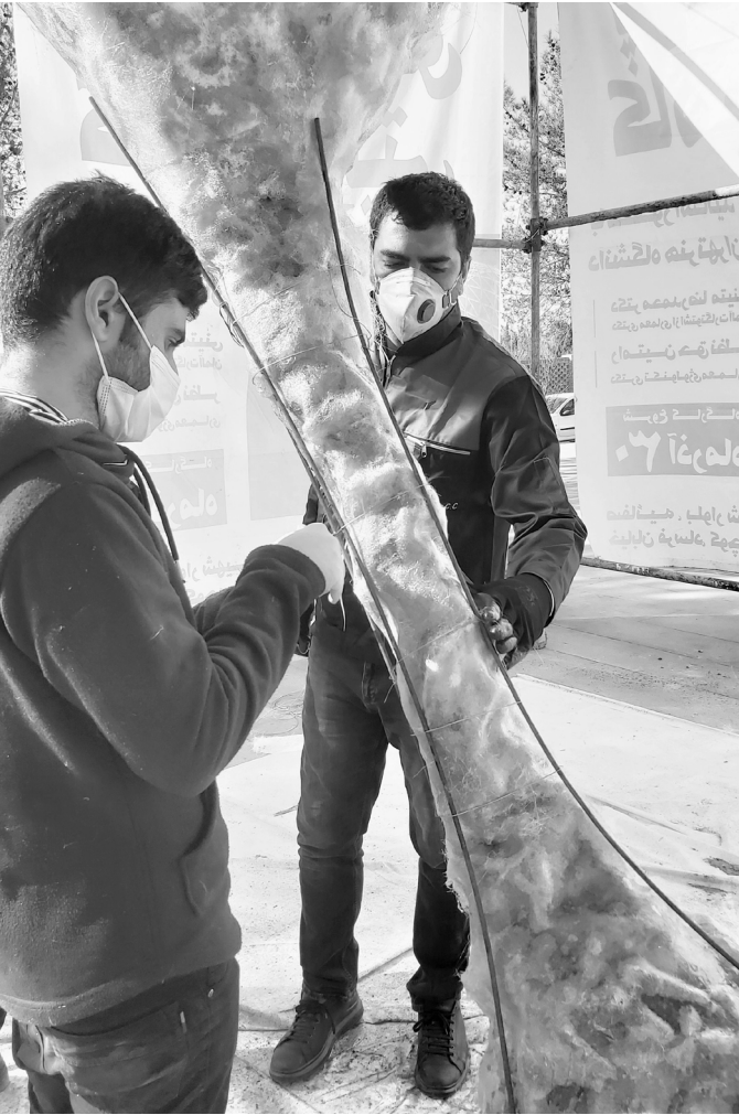
پس از ایجاد مسیر ستون ها، به وسیله پارچه فرم ستون ها تکمیل گردیده. سپس تمام سطح سازه به وسیله ی GFRP مقاوم سازی شده است. After creating the path of the columns, their form is completed by the fabric. Then the entire surface of the structure is reinforced with GFRP.
