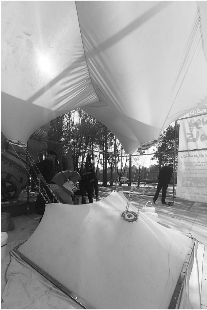
مقاوم سازی پارچه با استفاده از رزین پلی استر و الیاف شیشه ۴۵۰ گرمی در حداقل ۴ لایه Fabric reinforcement using polyester resin and 450 g fiberglass in at least 4 layers.
