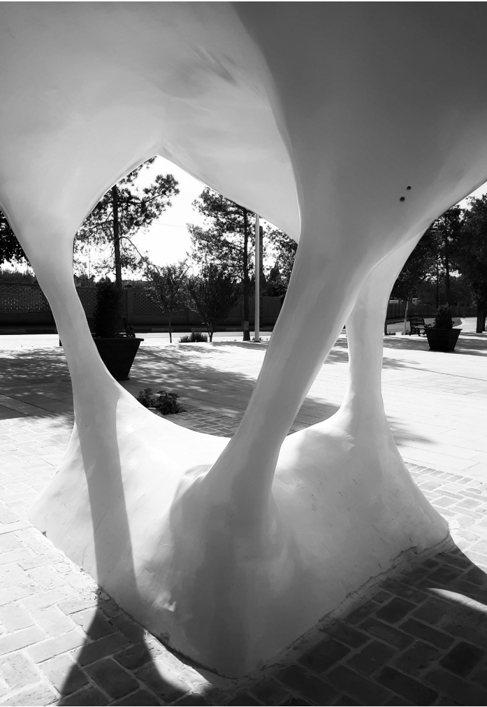
مقاوم سازی پارچه با استفاده از رزین پلی استر و الیاف شیشه ۴۵۰ گرمی در حداقل ۴ لایه Fabric reinforcement using polyester resin and 450 g fiberglass in at least 4 layers.
