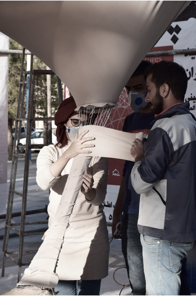
پس از ایجاد مسیر ستون ها، به وسیله پارچه فرم ستون ها تکمیل گردیده. سپس تمام سطح سازه به وسیله ی GFRP مقاوم سازی شده است. After creating the path of the columns, their form is completed by the fabric. Then the entire surface of the structure is reinforced with GFRP.
